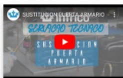
Sustitución puerta de un armario
