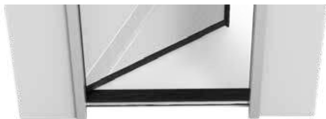
Détail de la passerelle
